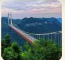
สะพานอ้ายจ้าย
